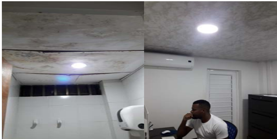
Cambio cielo raso en la oficina y baño de Registros Públicos
