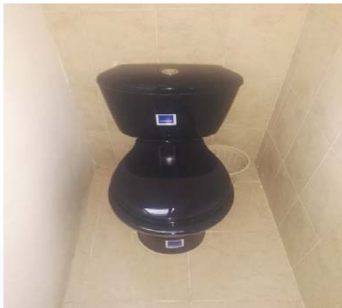
Cambio Sanitario del Baño de damas del 4to piso
